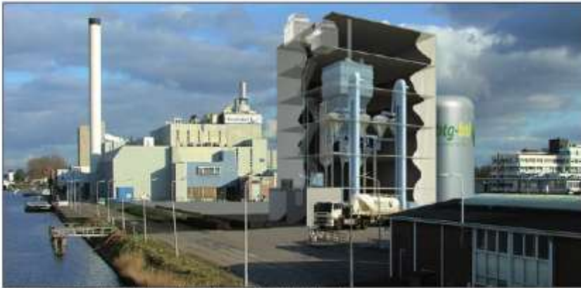
En impressie van de pyrolyse-installatie van BTG op het terrein van Akzo Nobel in Hengelo
